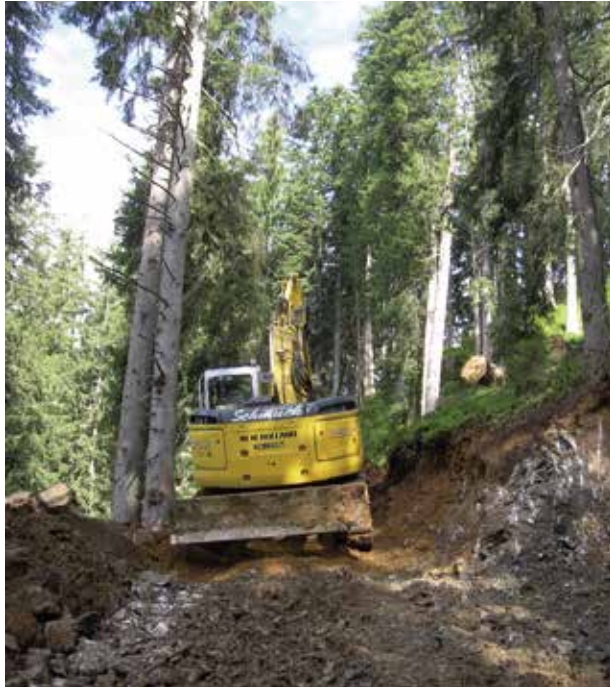
Rückwegegebau zur maschinellen Holzbringung am Litzlkogl, 2011
