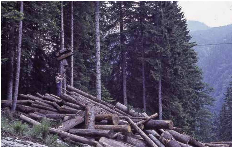
Holzbringung mit Seilzuganlage zum Zwischenlager an der Forststraße um 1970
