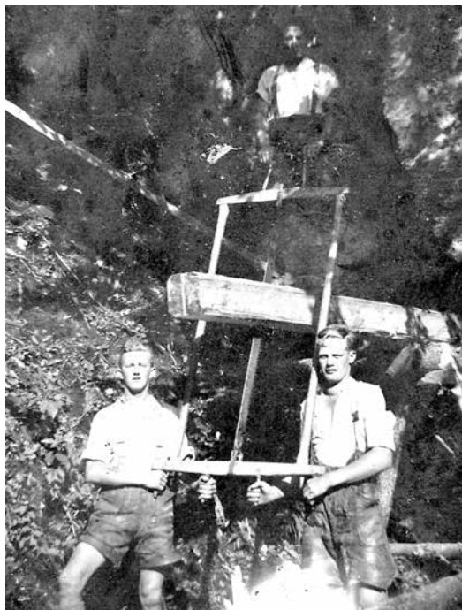
Dreimannsäge zum Bauholzschneiden für die Errichtung einer winterfesten Holzknechtstube, ca. 1930
