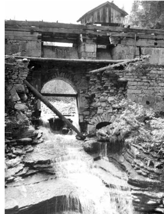
Muck-Klause, Triftbauwerk aus 1792, dahinter Stauraum für ca. 14.000 Kubikmeter Wasser als Haupttriftwasser
